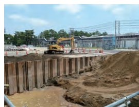
汚染土壌の掘削除去作業の様子
